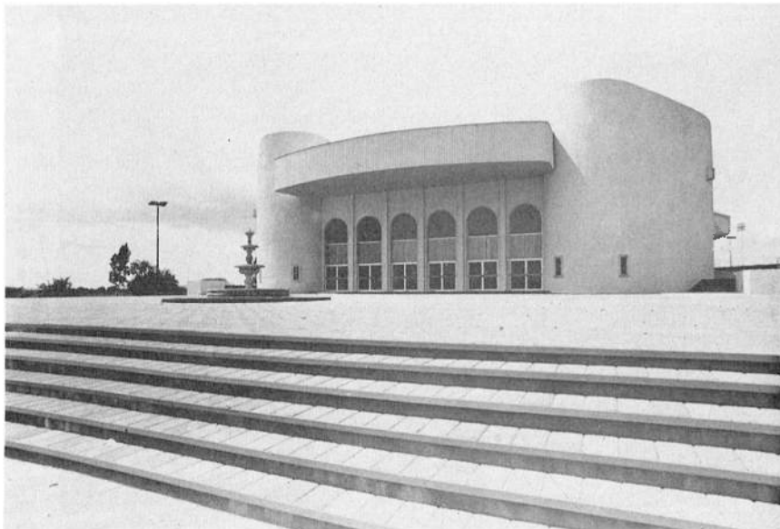
Edificio de la Biblioteca Pública Municipal -que cuenta con auditorio cívico-, de Navojoa, parte de la Red Estatal y Nacional de Bibliotecas.
